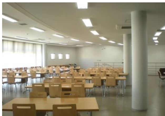
LED照明施工実績
